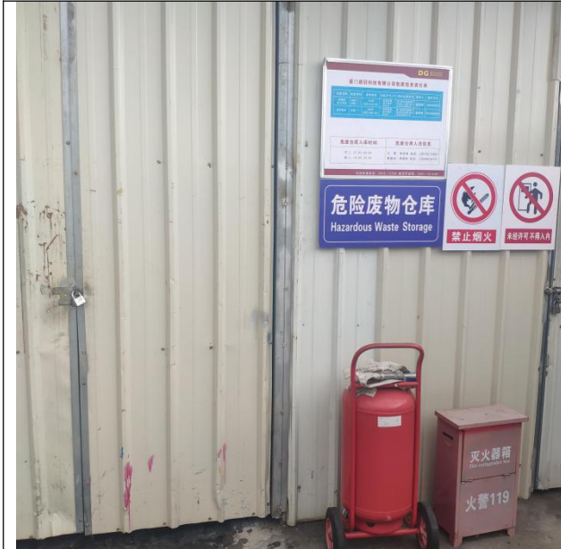
危险废物仓库灭火器
