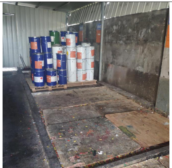
危险废物仓库托盘、导流沟
