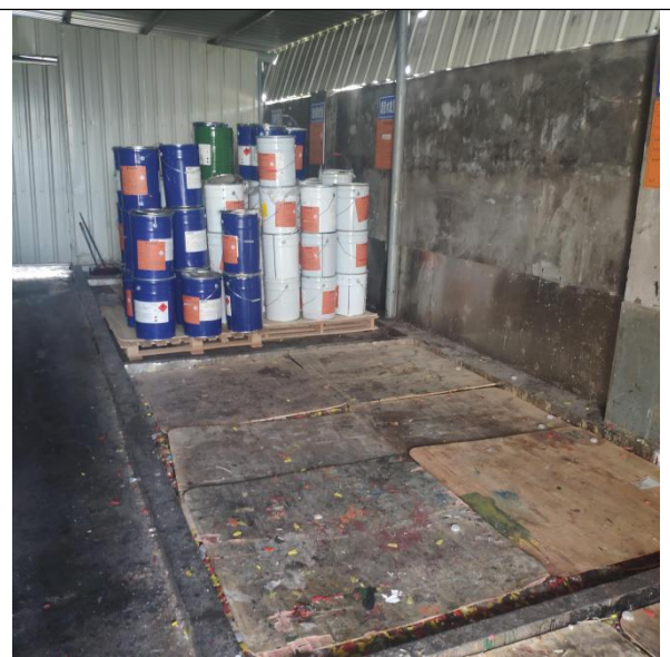
危险废物仓库托盘、导流沟
